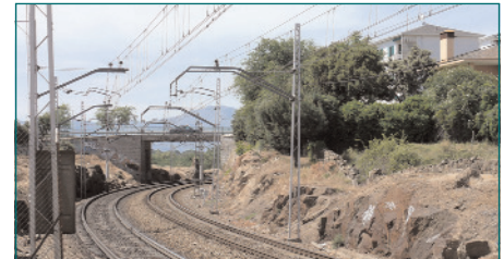
Puente y viviendas al lado de la estación La Navata.
